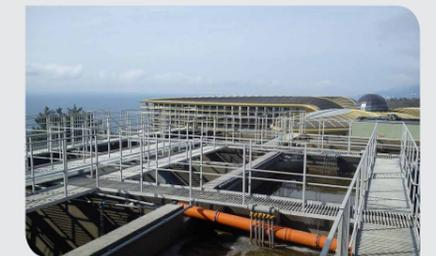
Установки железобетонного исполнения изготавливаются производительностью от 10 до 2400 м³/сутки.
