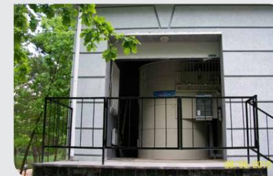
Блочно-модульные наземные установки применяются при высоком уровне грунтовых вод и изготавливаются производительностью от 10 до 300 м³/сутки. Для очистки сточных вод объемом более 300 м³/сутки используются несколько типовых, параллельно работающих установок. Монтаж таких установок возможен в существующих зданиях.
